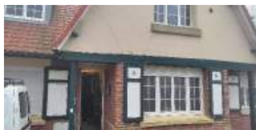
Devant le futur logement
