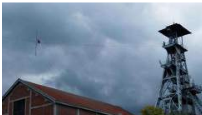
Traversée funambule entre 2 des chevalements du site minier d'Arenberg lors de l'événement "Traversée(s)" ©Mission Bassin Minier
